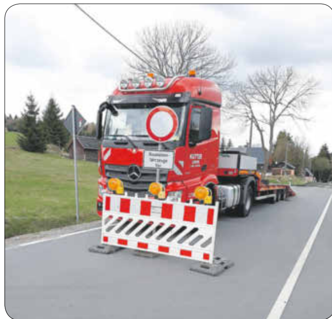
Grundinstandsetzung der Staatsstraße S271
